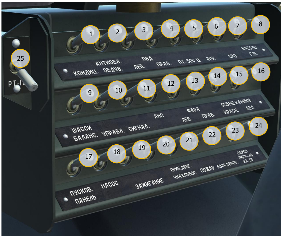
Рис. 97. Вспомогательный электрощиток передней кабины
